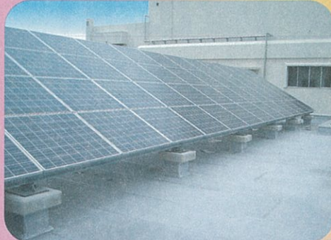
毎時10kW以上の電気をつくる太陽光パネル
